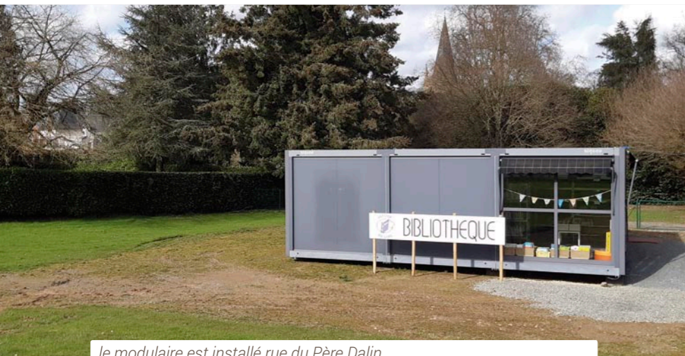
Le modulaire est installé rue du Père Dalin.
