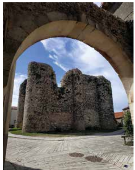
Donjon - Les Châtelliers-Châteaumur
